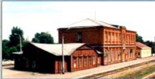
Общий вид станции Астапово.
